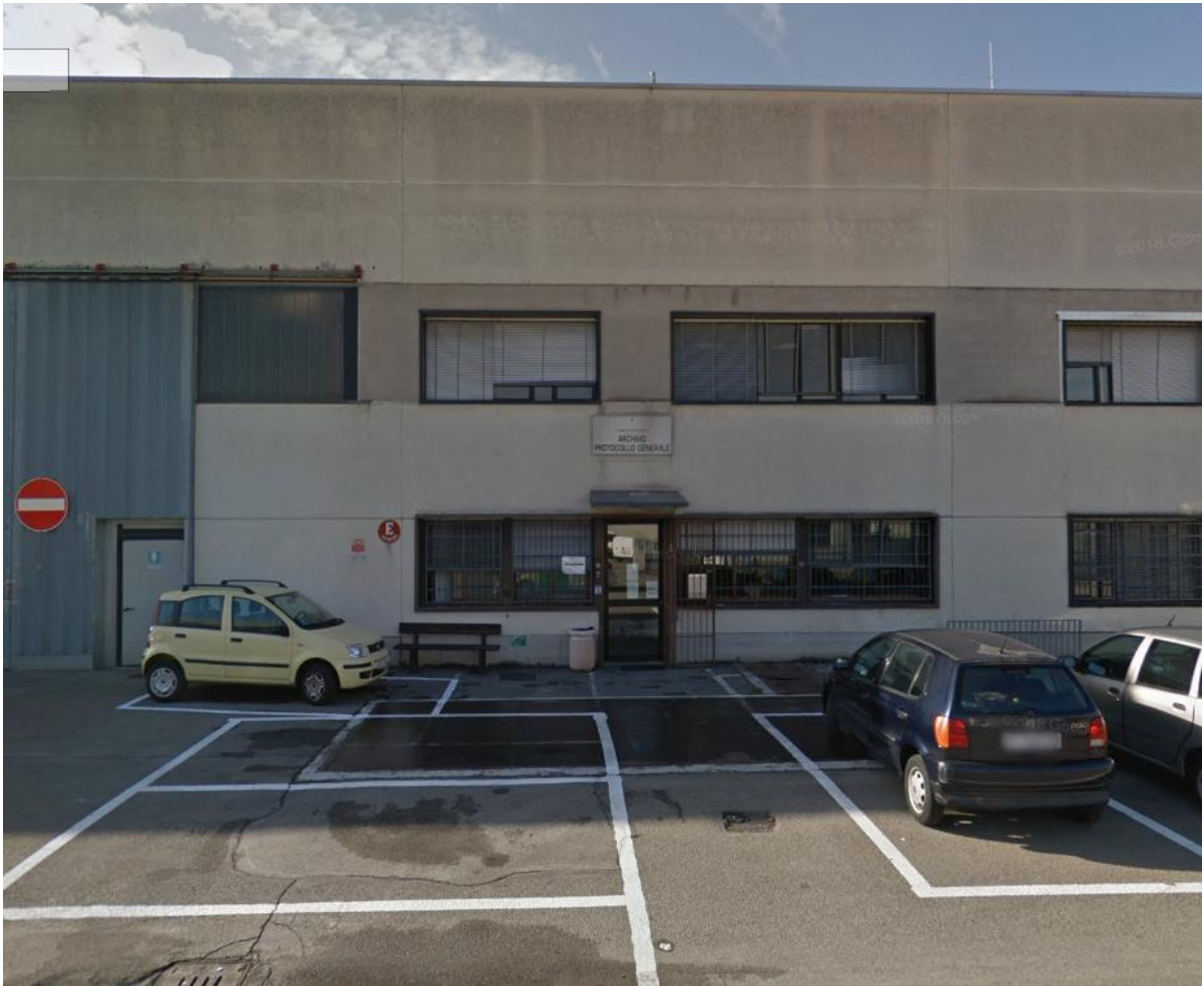
Vista ingresso Archivio Generale del Comune di Reggio Emilia
